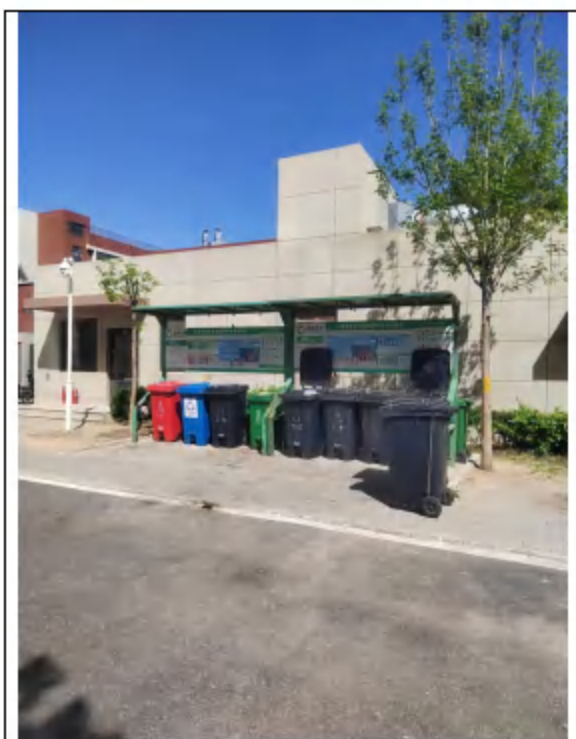
生活垃圾收集装置
