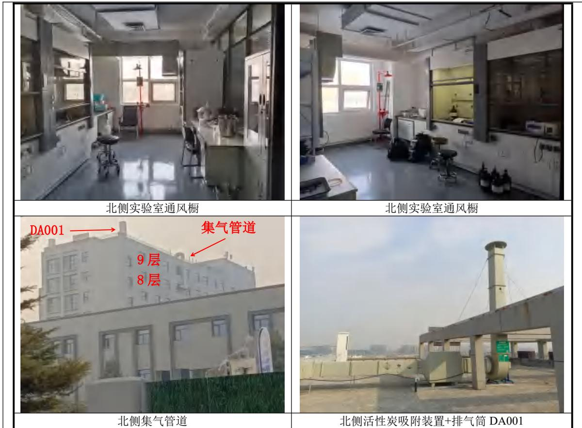
图 3-1 北侧实验室废气处理设施(排气筒 DA001)现状照片
