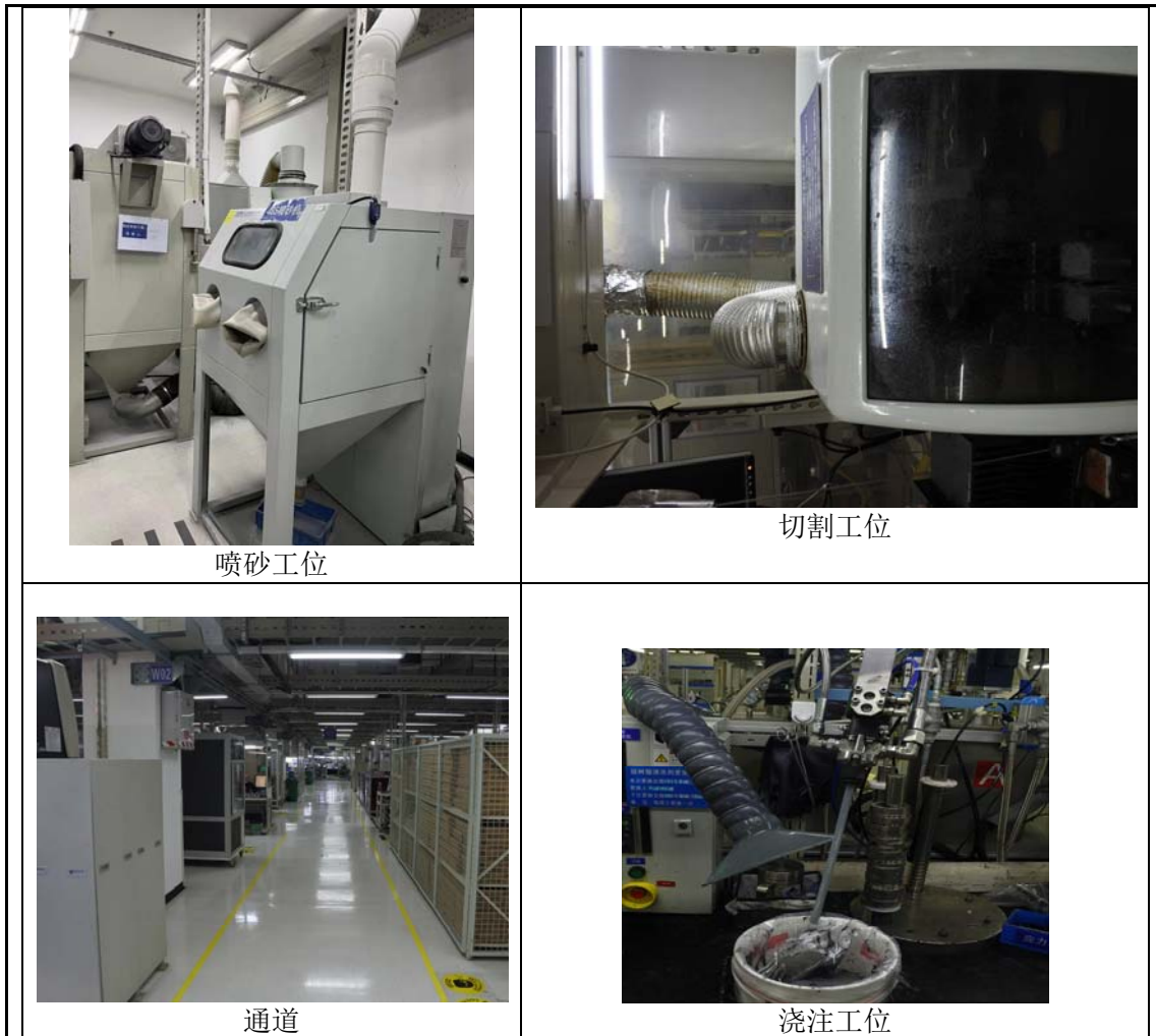
图 2-1 生产车间及焊接工位、喷砂工位、切割工位、浇注工位照片
