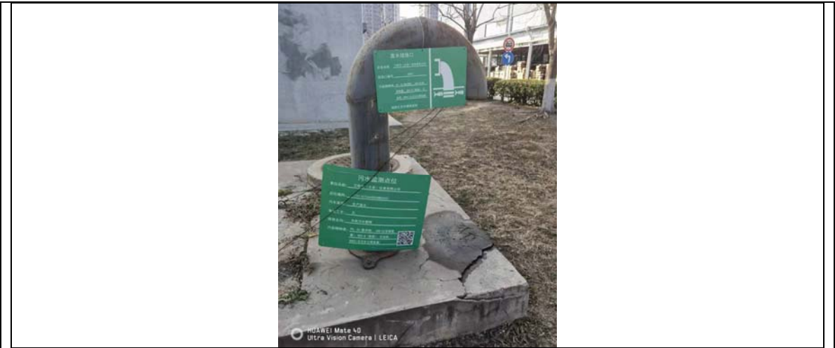
图 3-2 集水池及废水排放口标识
